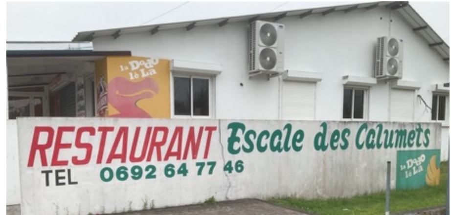
Enseignes parallèles au mur peintes
