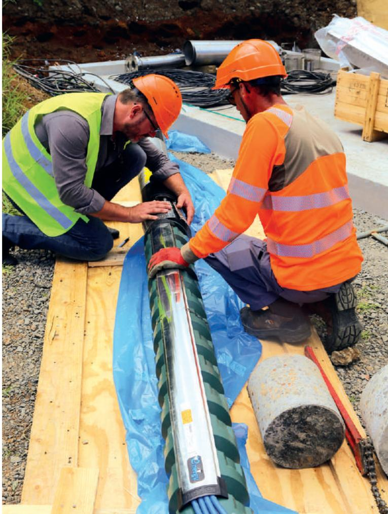
Les ingénieurs en train de terminer le montage de la pompe de forage
