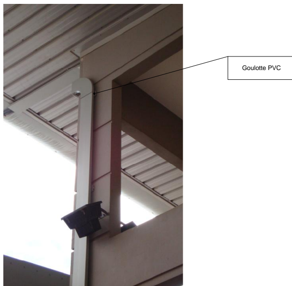
FIGURE 12 : GOULOTTE PVC POUR DESCENTE DE CABLE
